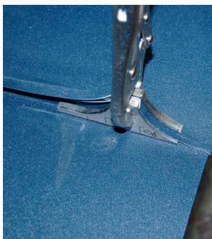
KROK 5. Zagięcie blachy na prasce okapu
