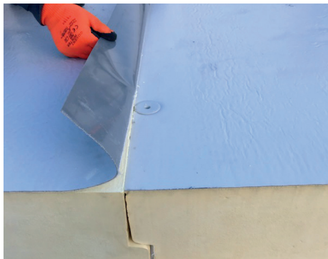
ThermaMembrane – umiejscowienie łącznika
