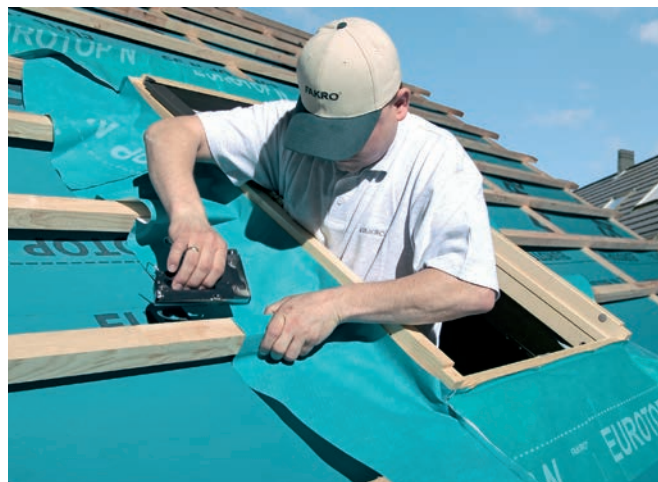
Boki kołnierza można wyłożyć bezpośrednio na łąty, bez konieczności ich nacinania i niezależnie od ich grubości oraz rozstawu
